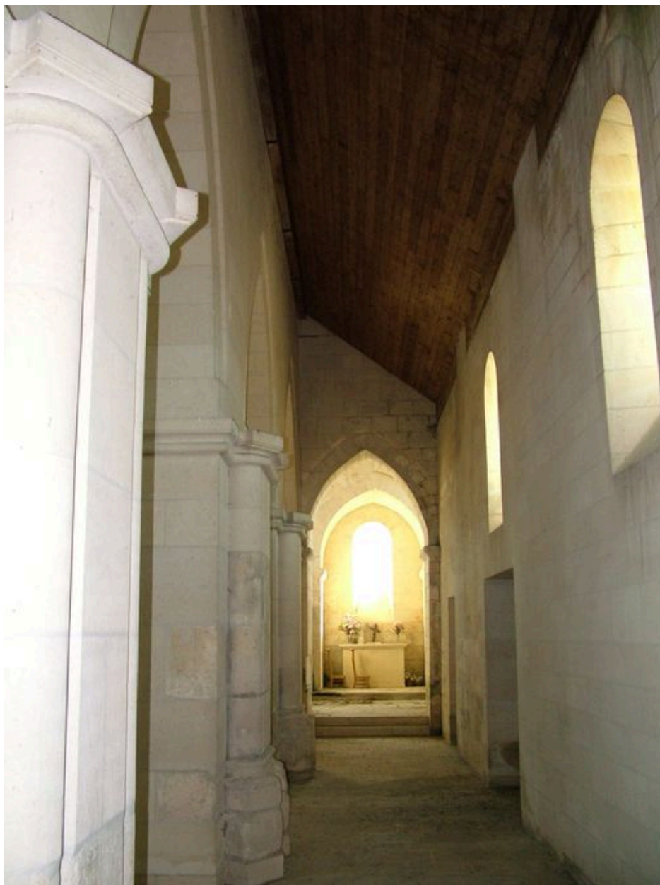
Vue du collatéral nord.
