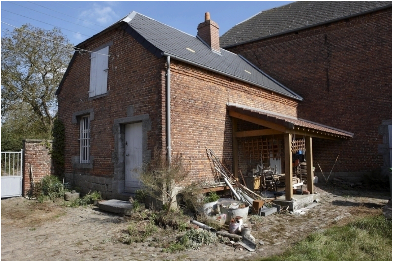
Vue du bâtiment situé à l'entrée de la cour.
