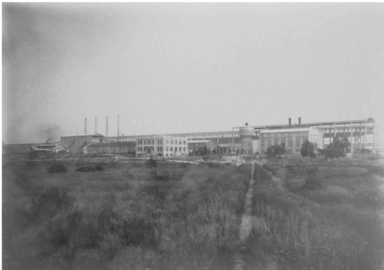
Vue générale de l'entreprise, vers 1930. Au centre les grands bureaux détruits en 1965. (AC Thourotte).
