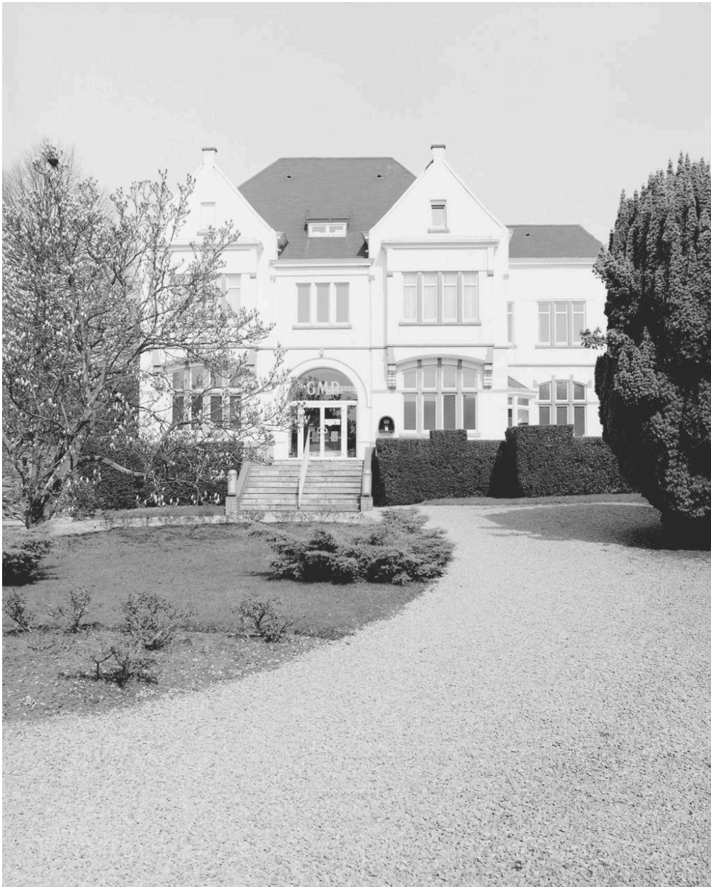
Maison sise rue de l'Hôtel-de-Ville à Aulnoye-Aymeries, construite dans l'entre-deux-guerres.
