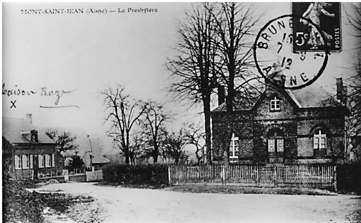
Vue de l'ancien presbytère, avant sa transformation en laiterie (AP).
