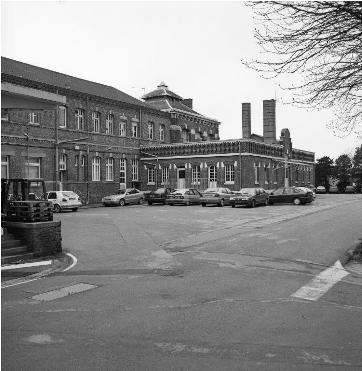
Bâtiment des cuisines, élévation latérale droite, vue générale prise de trois quarts gauche.
