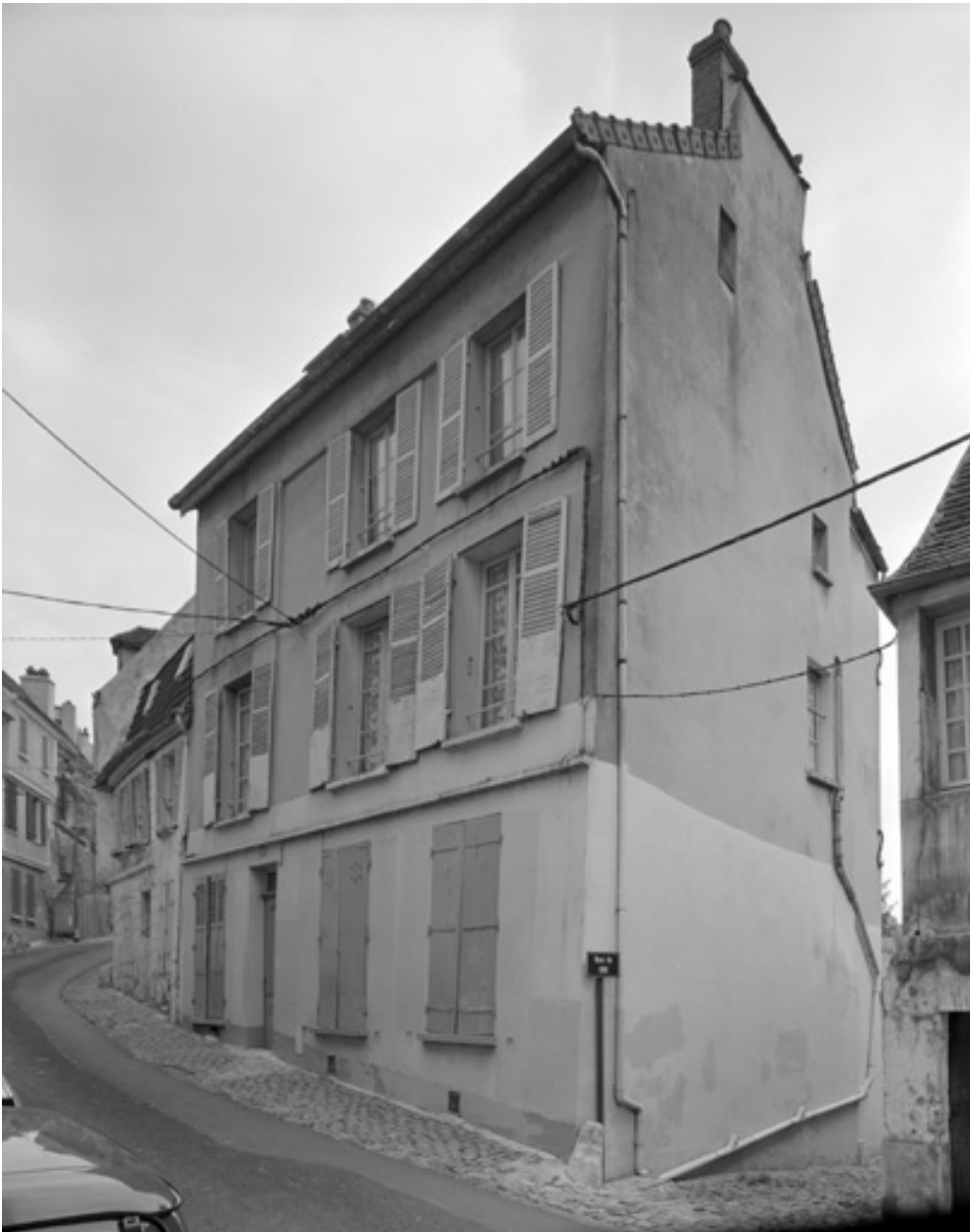
Vue d'ensemble depuis la rue.
