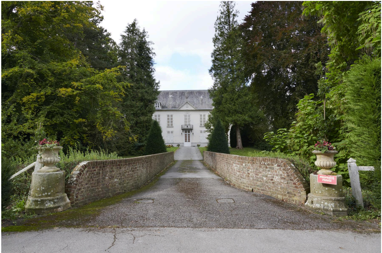
Vue vers la façade principale, avant le pont de brique.
