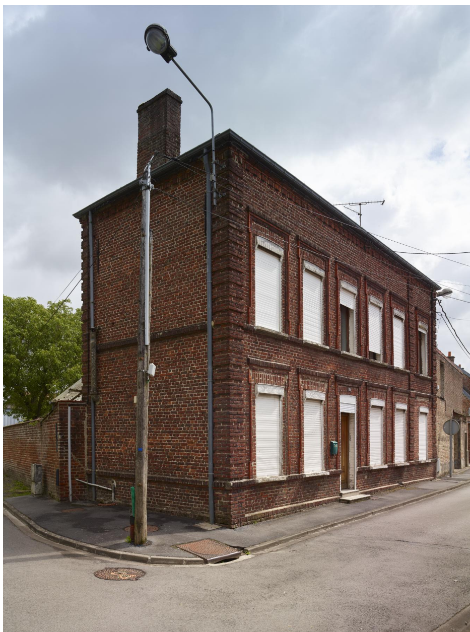
Façade sur la rue de Goa et façade latérale gauche, vue orientée est/ouest.
