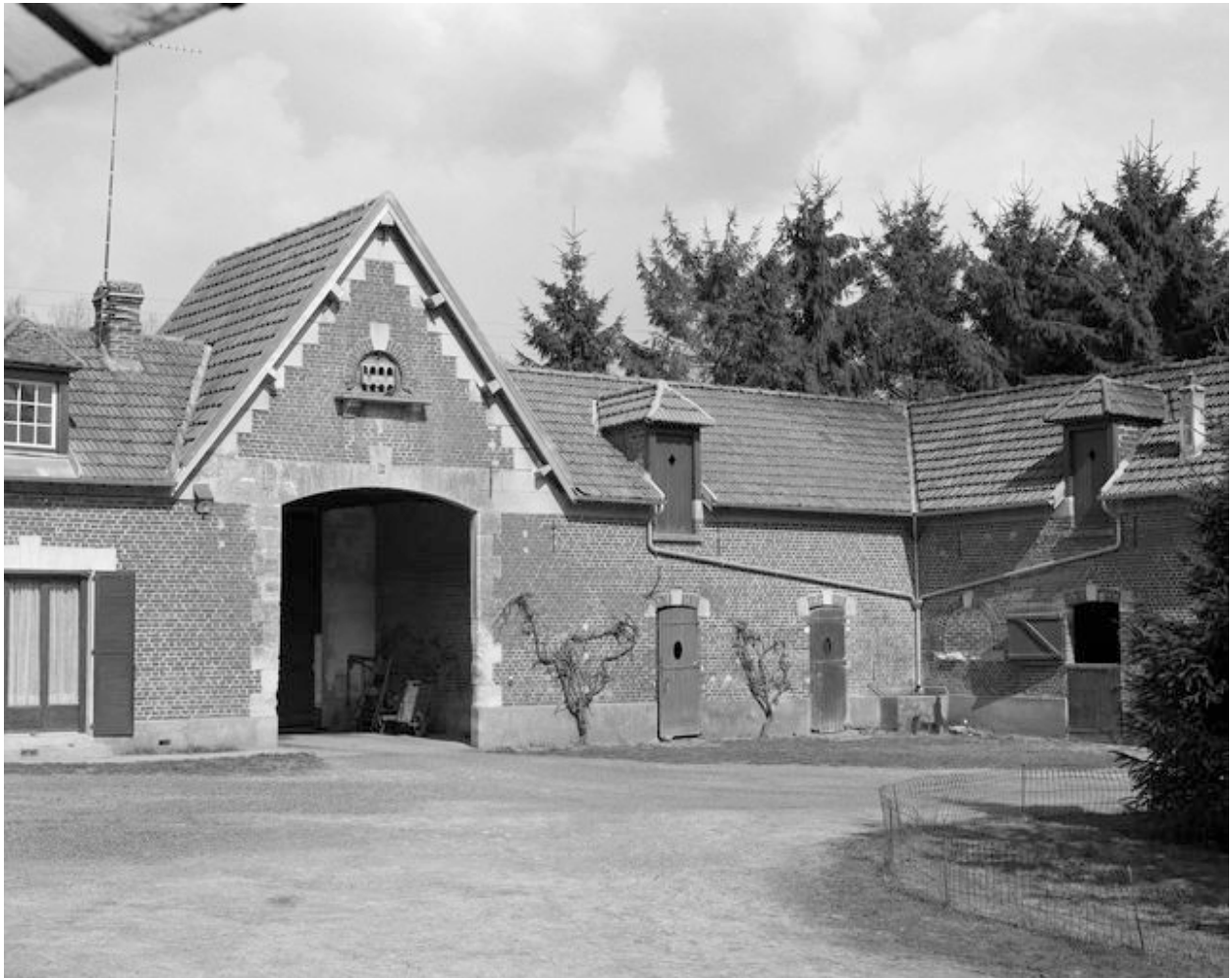
Portail, pigeonnier et écuries, depuis la cour.
