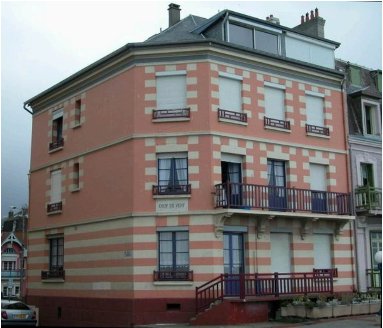
Vue d'ensemble depuis l'esplanade.
