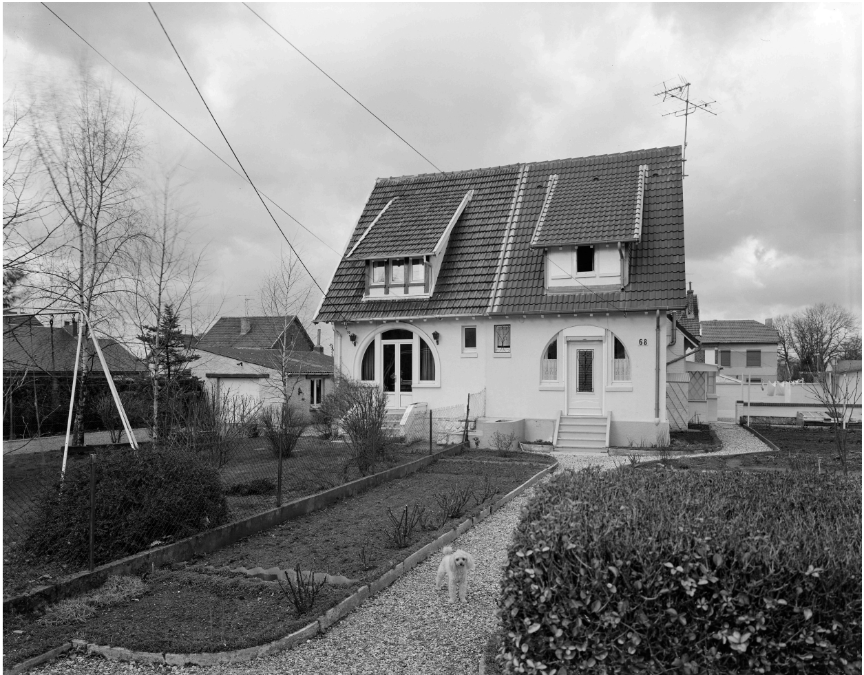
Module d'habitation, maisons jumelées sises aux 68-70 avenue du Général-Leclerc, élévations antérieures.
