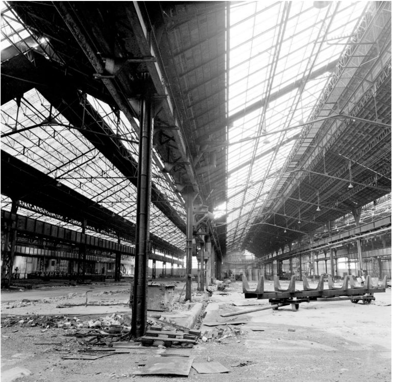
Vue intérieure des ateliers (usine B) .
