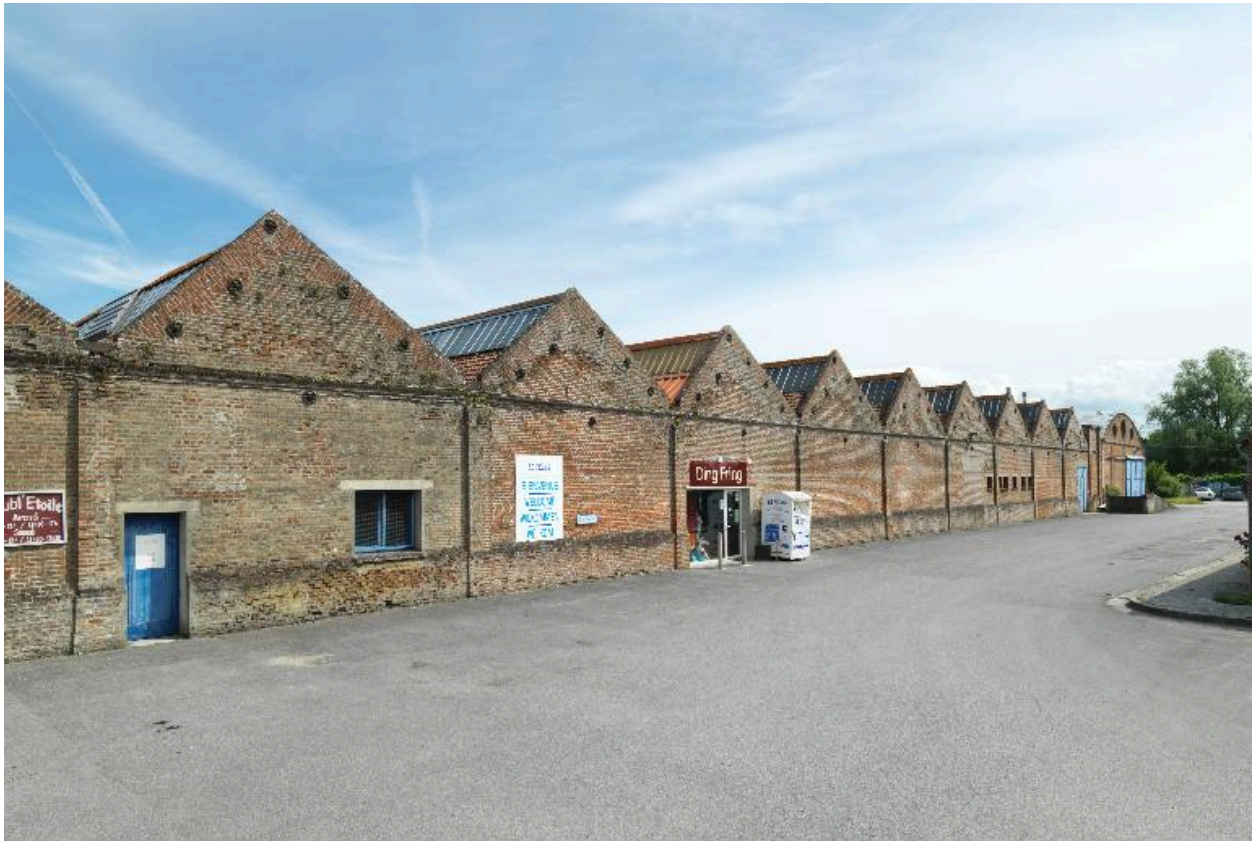
Vue d'ensemble nord-ouest de l'atelier de tissage.
