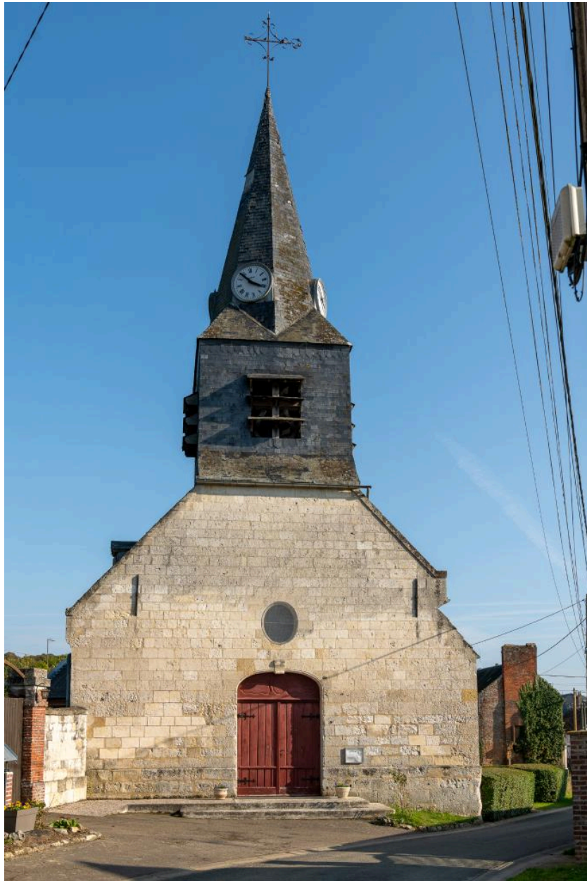
Vue de la façade occidentale.
