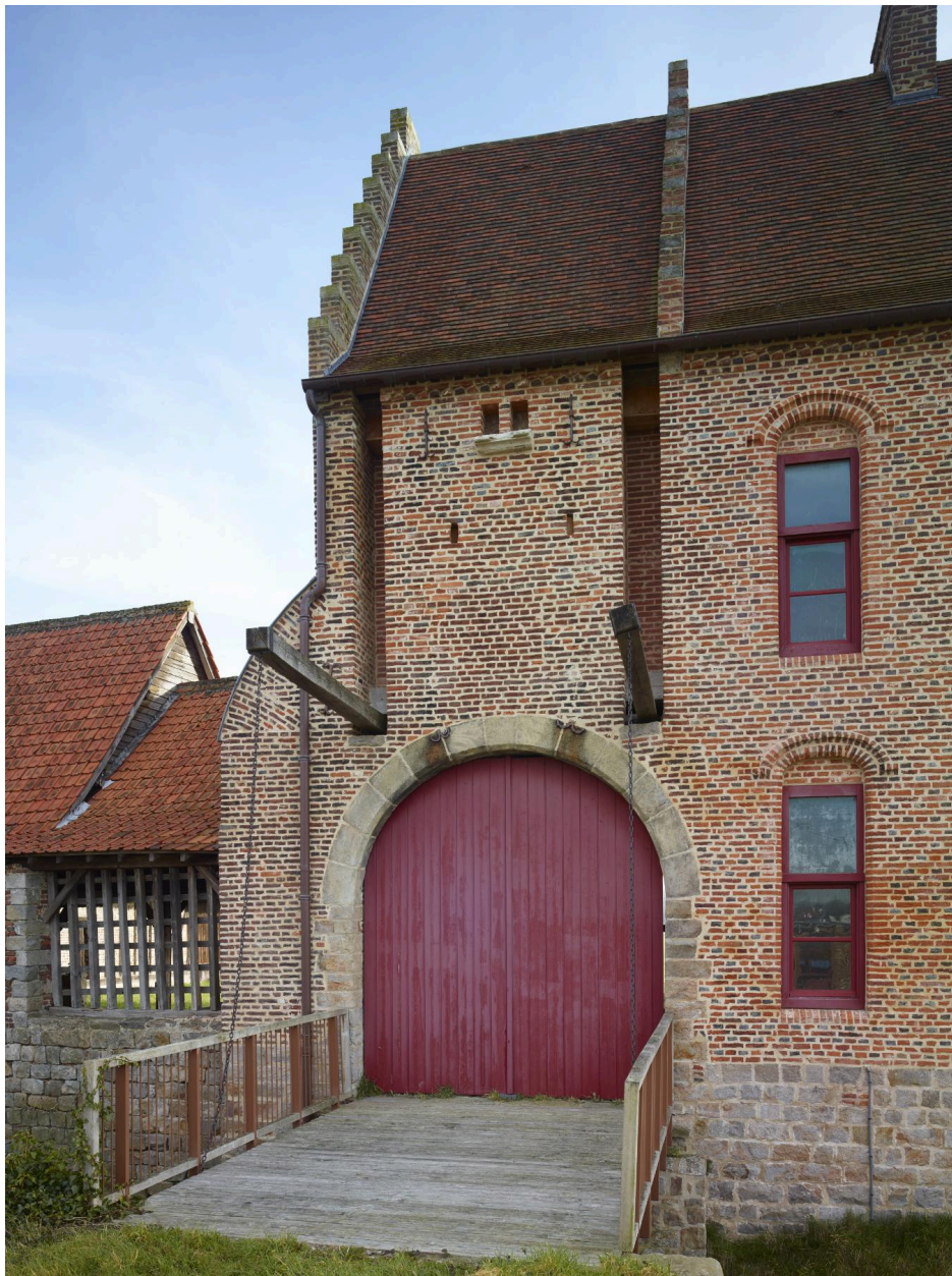
Tour-porche et porterie. Vue depuis la rue.
