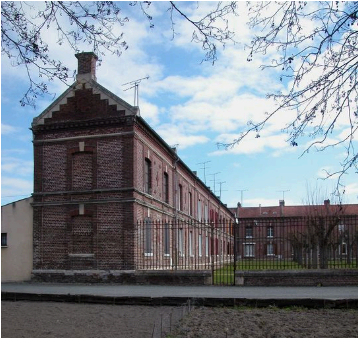
Vue d'ensemble du corps de bâtiment ouest.
