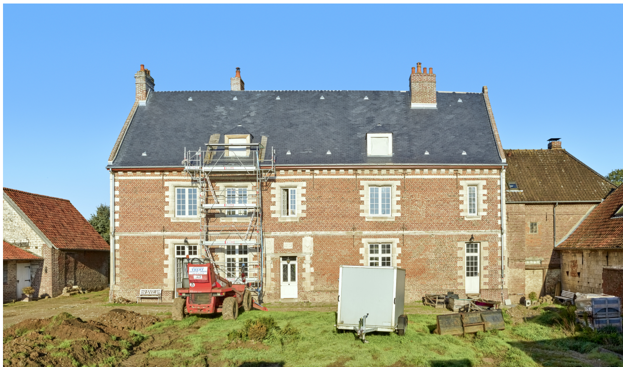
Façade sur cour.
