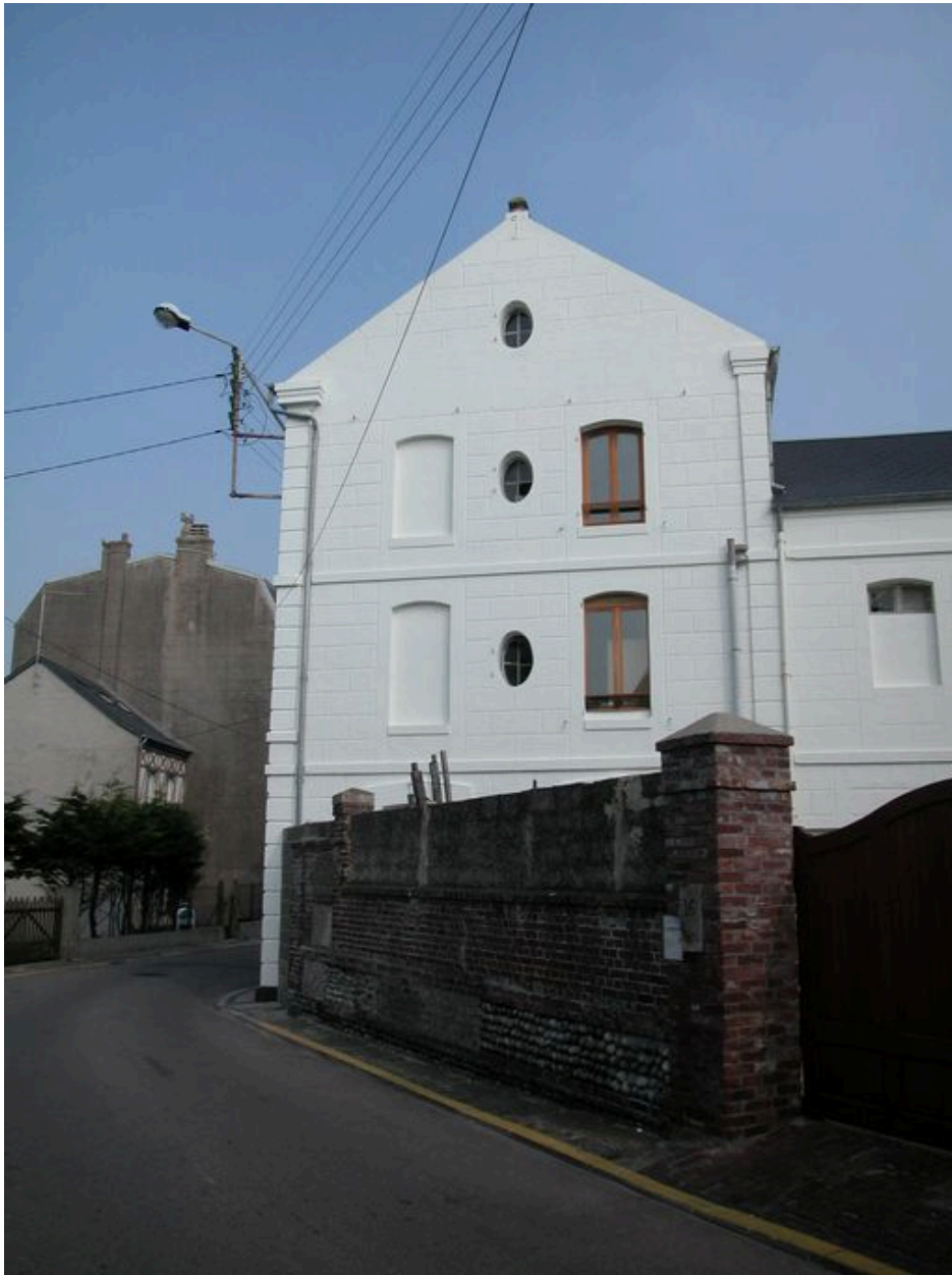
Vue de la façade latérale droite.
