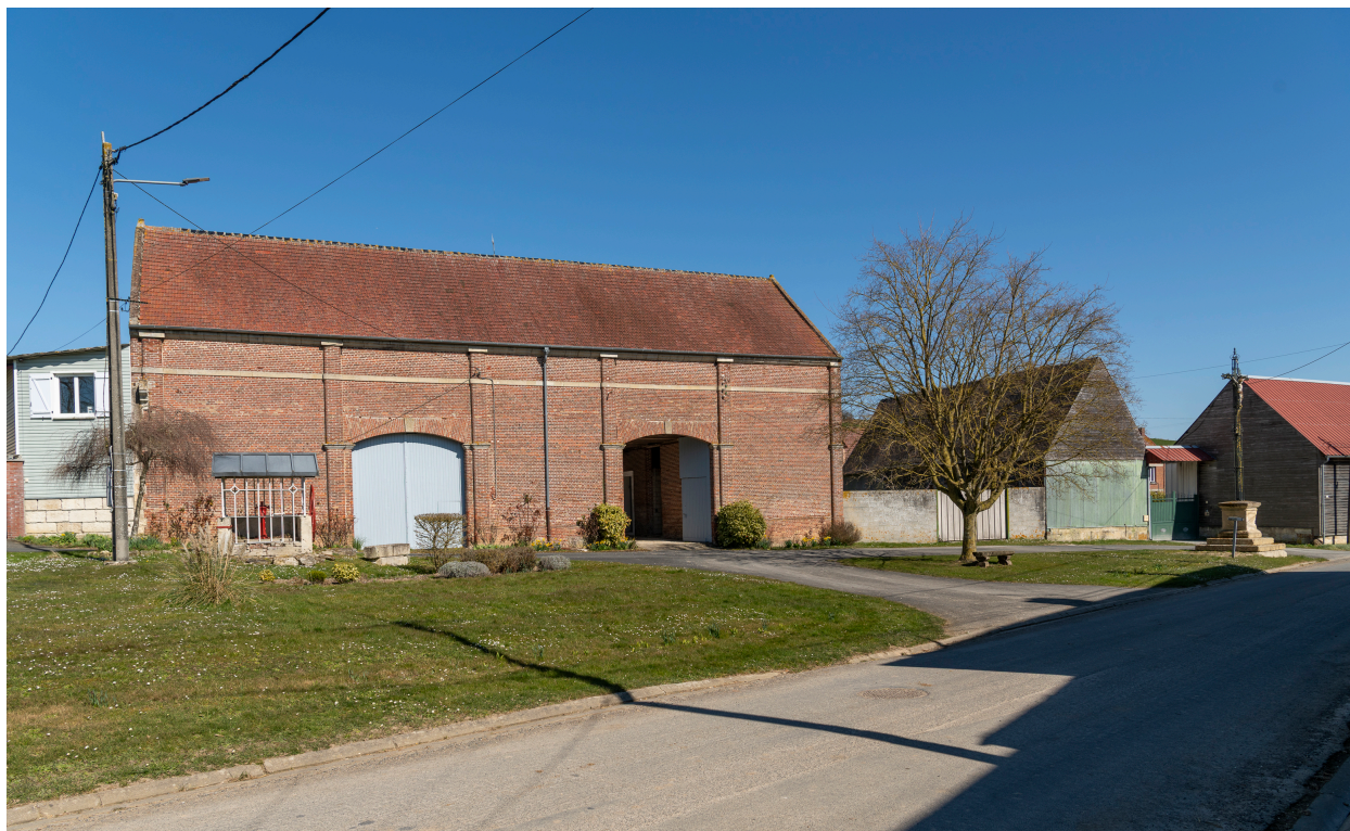
Vue générale de la Place depuis le sud.
