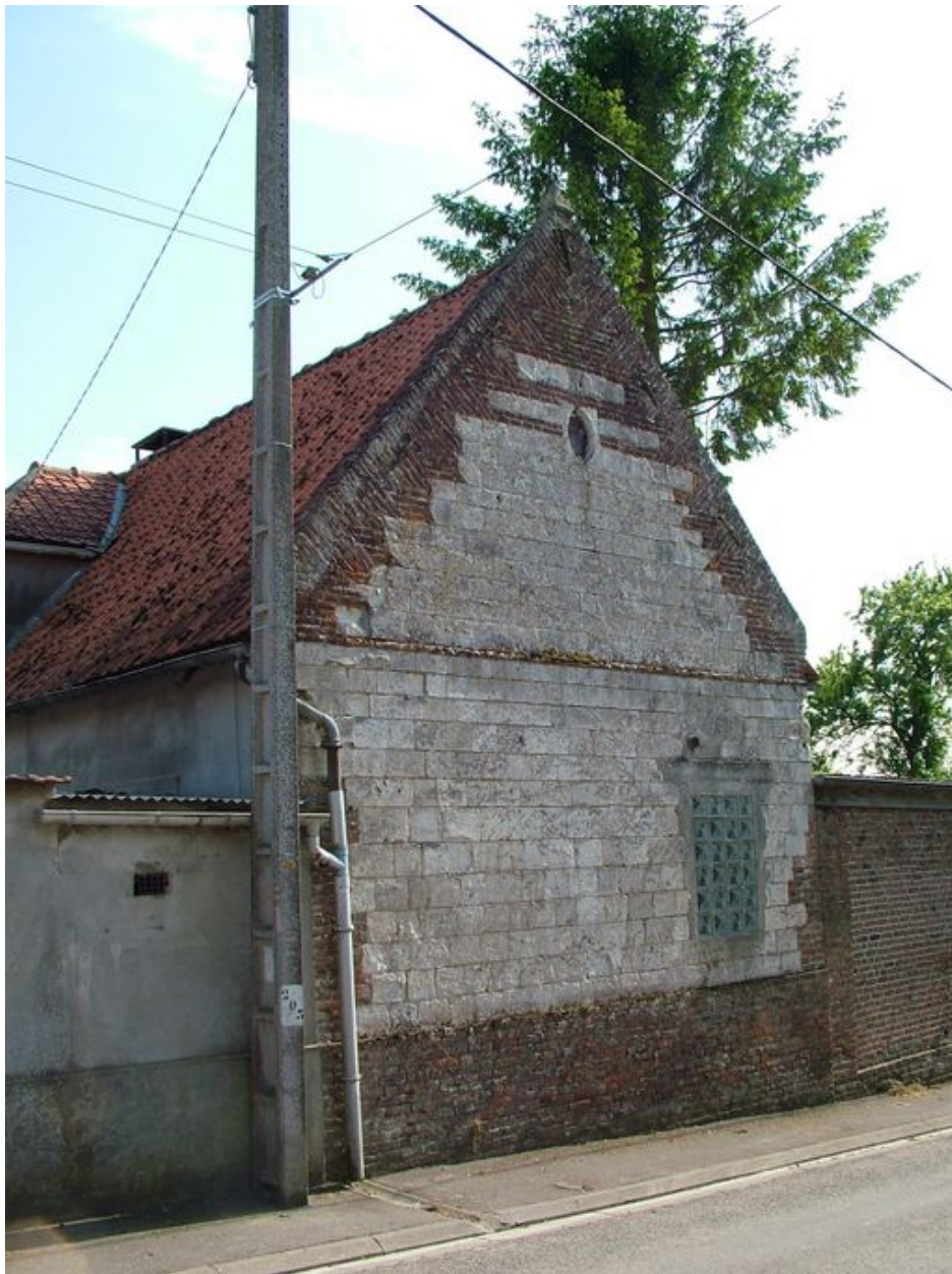
Pernois, pignon de l'ancien presbytère, 82 rue d'En-Haut, 18e siècle.
