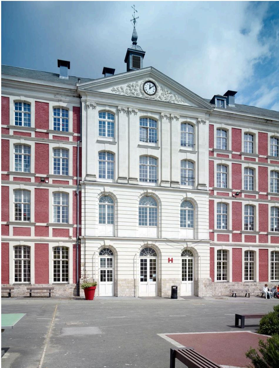
Détail de l'avant-corps central de l'aile de l'Horloge.
