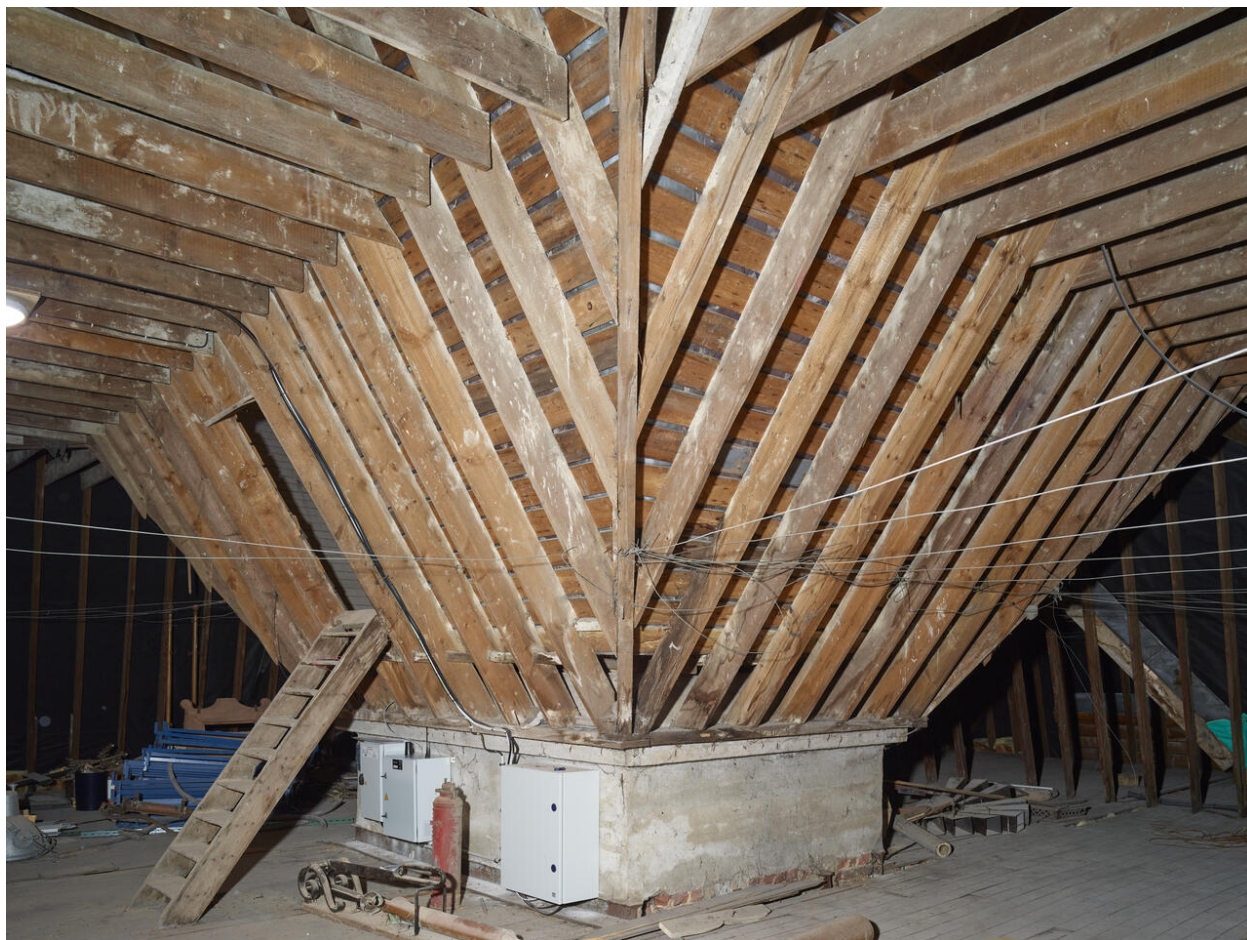
Vue des combles et des noues intérieures formant entonnoir de réception des eaux pluviales.
