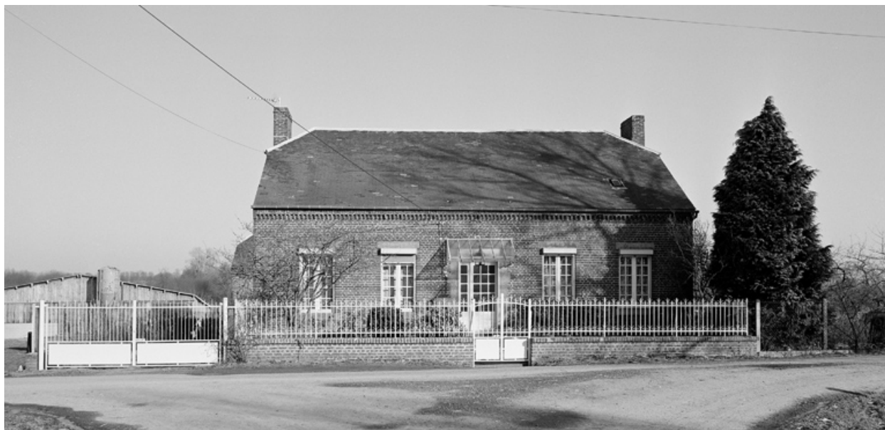
Façade du logis.
