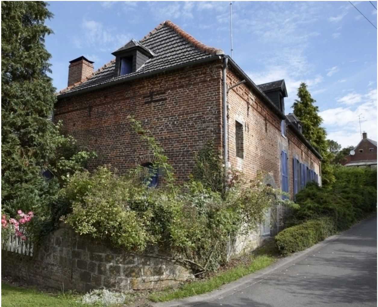
Vue du pignon sud du moulin.
