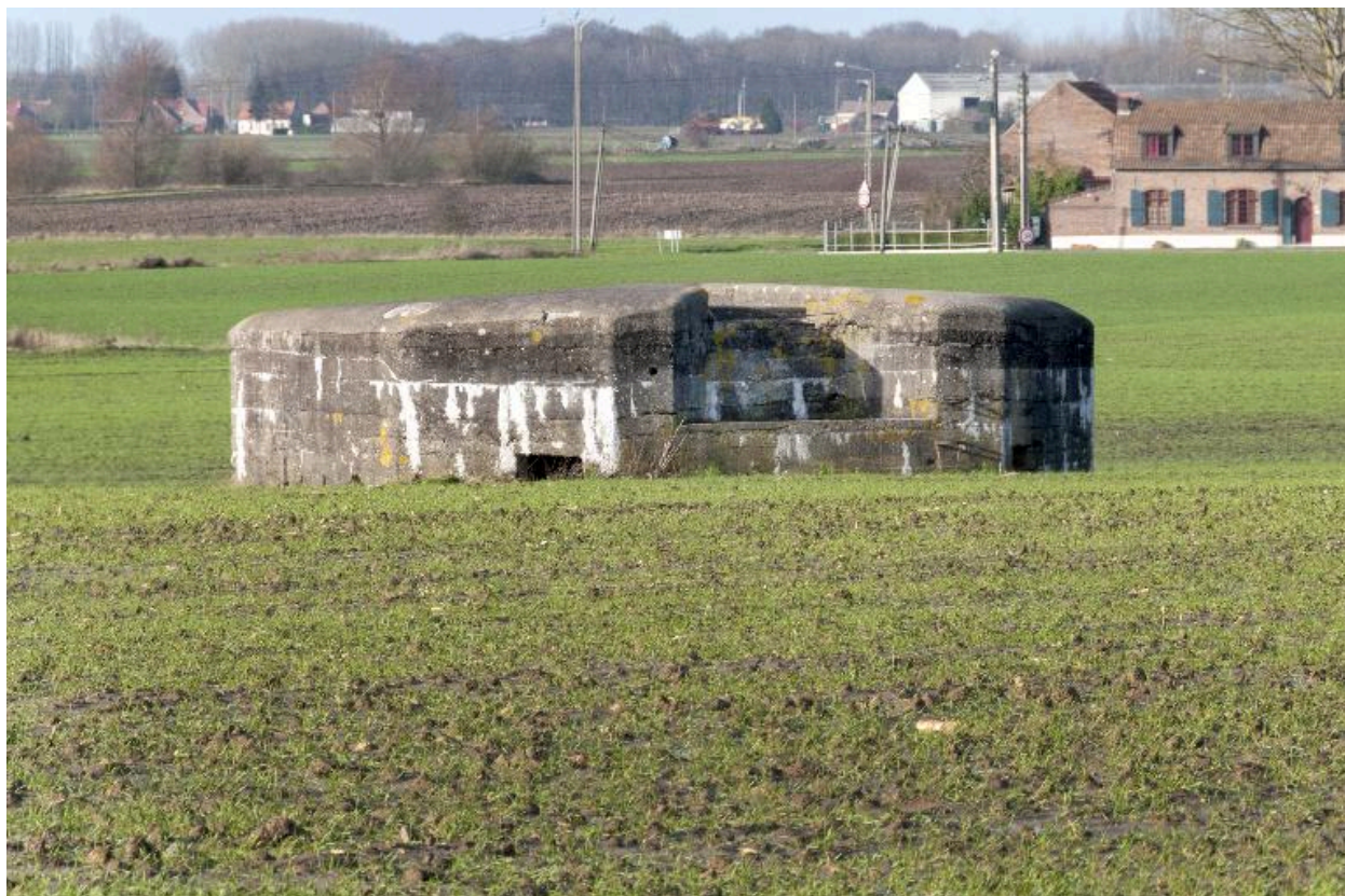
Vue générale vers le nord-ouest
