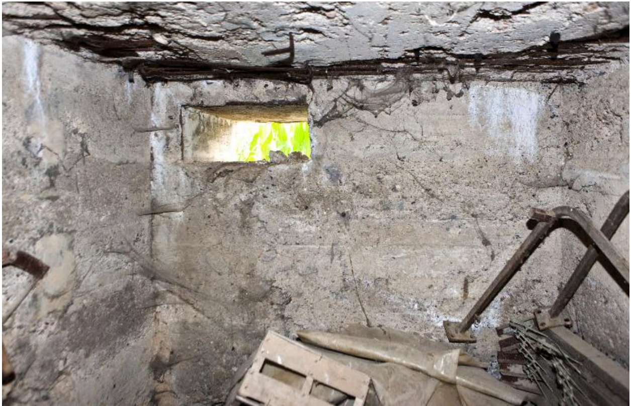
Vue intérieure, vers l'est
