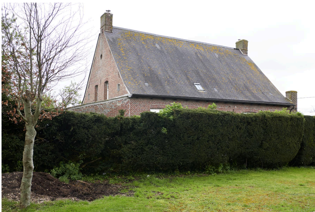
Vue de la toiture et du pignon sud de l'ancien presbytère depuis la route de Watten.
