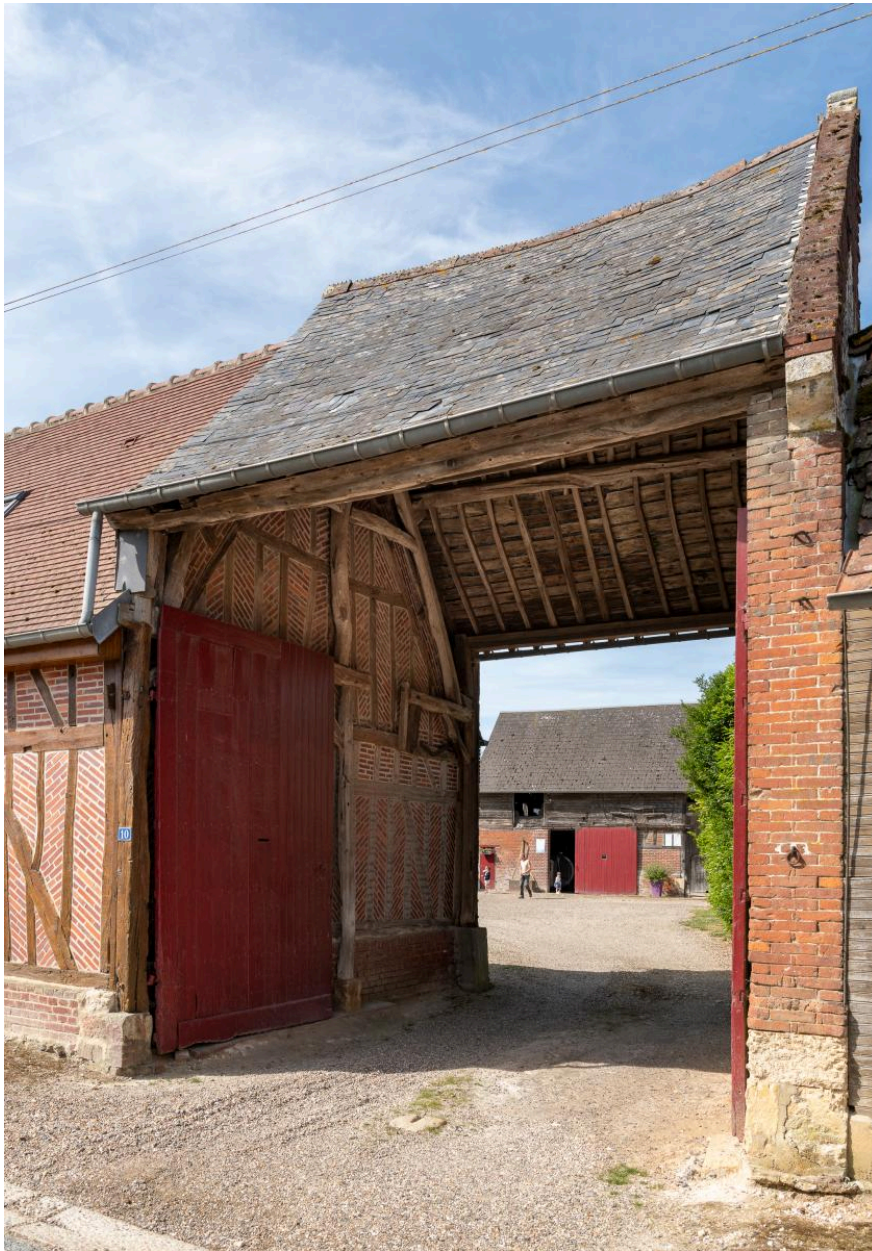
Entrée charretière sur rue, n°10 rue Tassart, vue depuis l'est.
