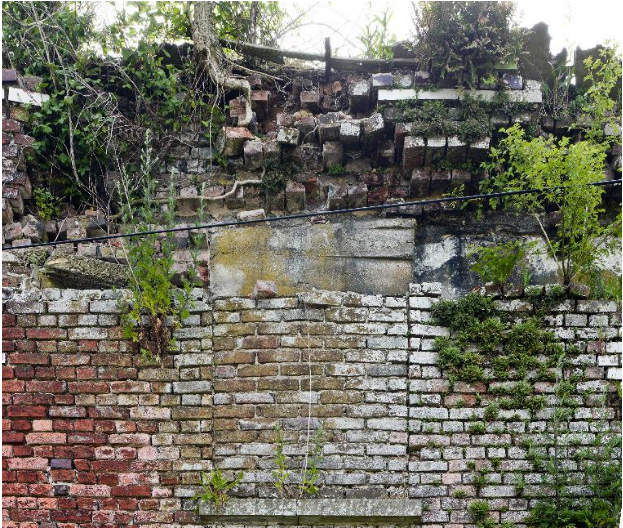
Elévation antérieure. Détail de la corniche cachant une embrasure de tir
