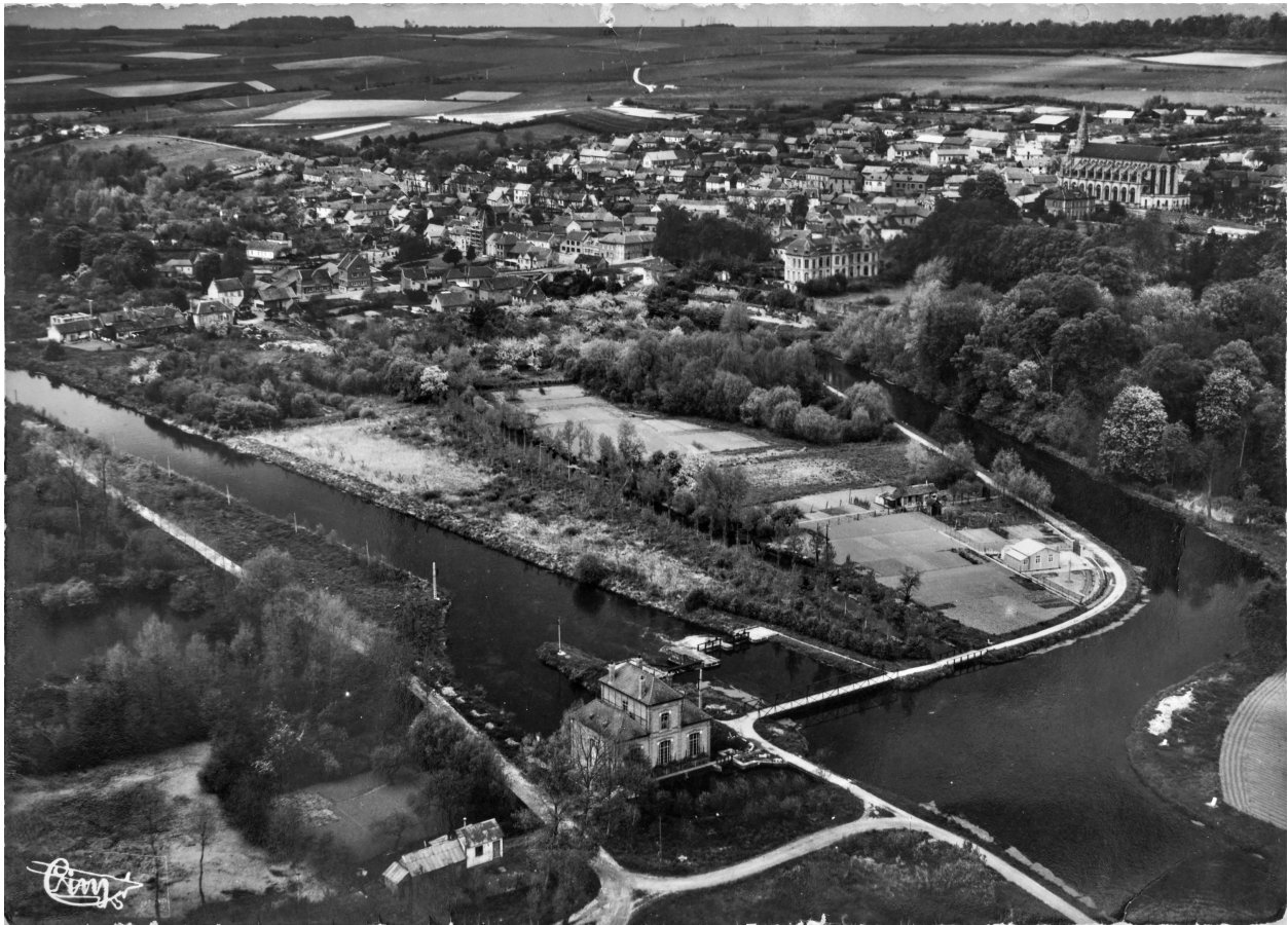
Vue aérienne de la centrale hydroélectrique, carte postale, Cim, ca 1949-1968 (coll. Jean-Paul Rouët).
