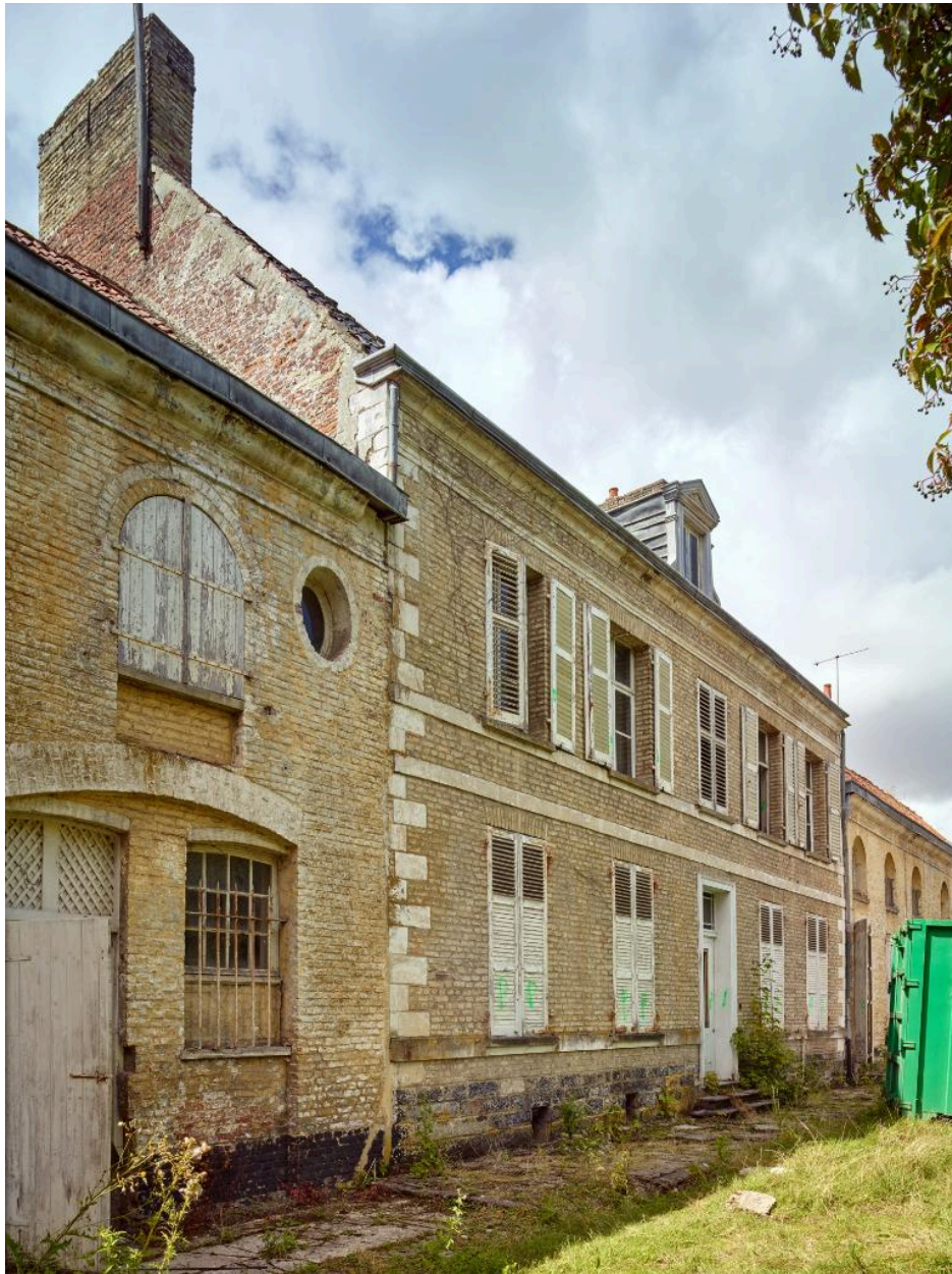
Ferme des Berceaux en 2018 : partie ouest de la ferme : détail de la façade du logis patronal depuis la cour.
