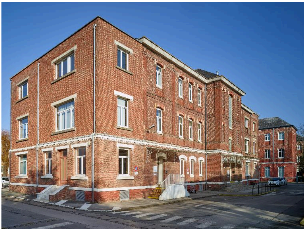
Bâtiment de l'administration, élévation antérieure, vue générale prise de trois quarts gauche.
