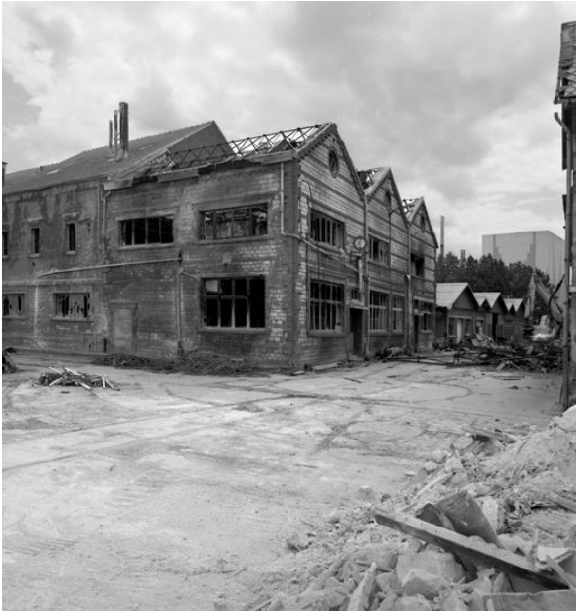
Démolition du laboratoire d'essais.
