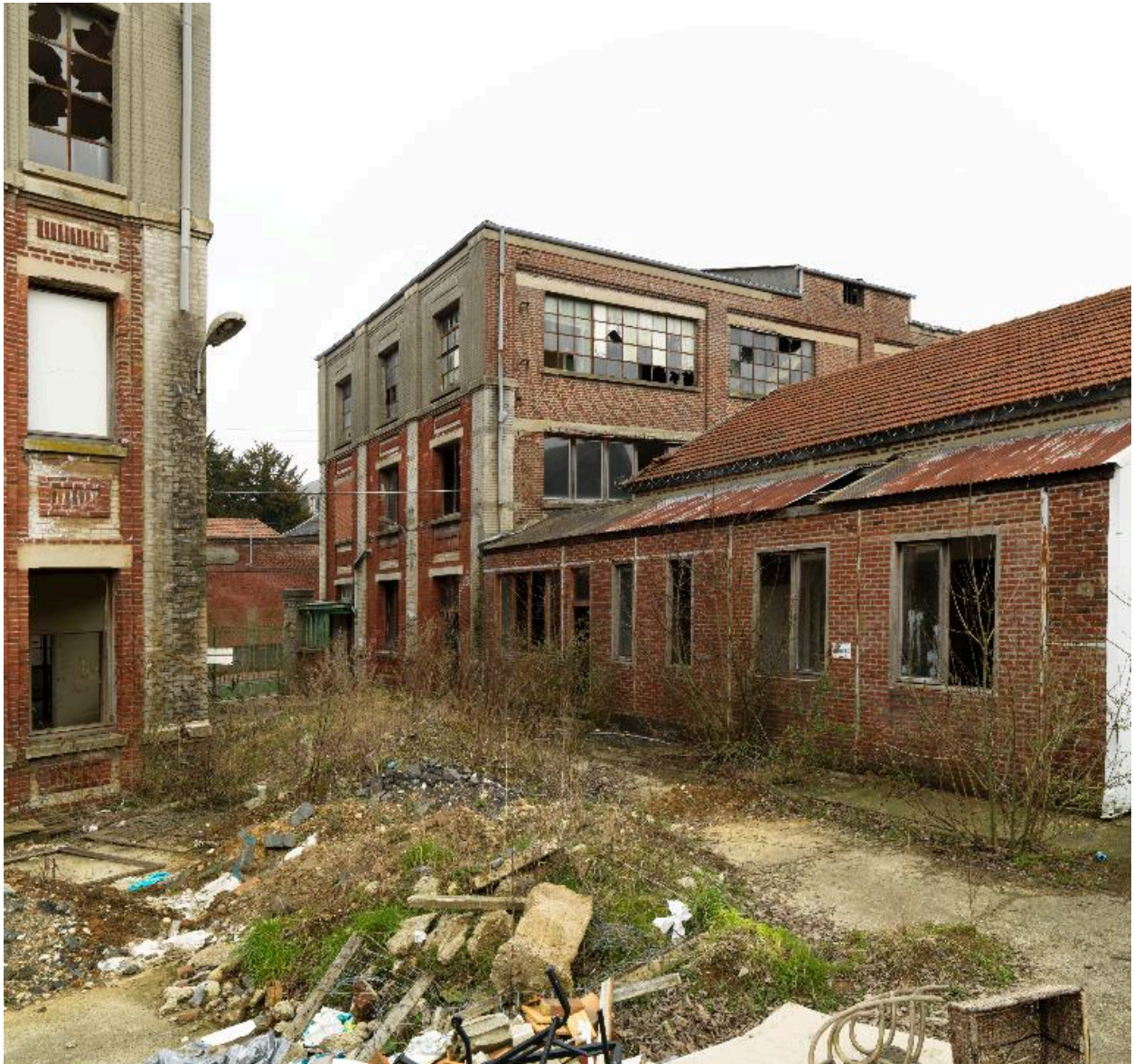
Vue du bâtiment principal nord, depuis la cour.
