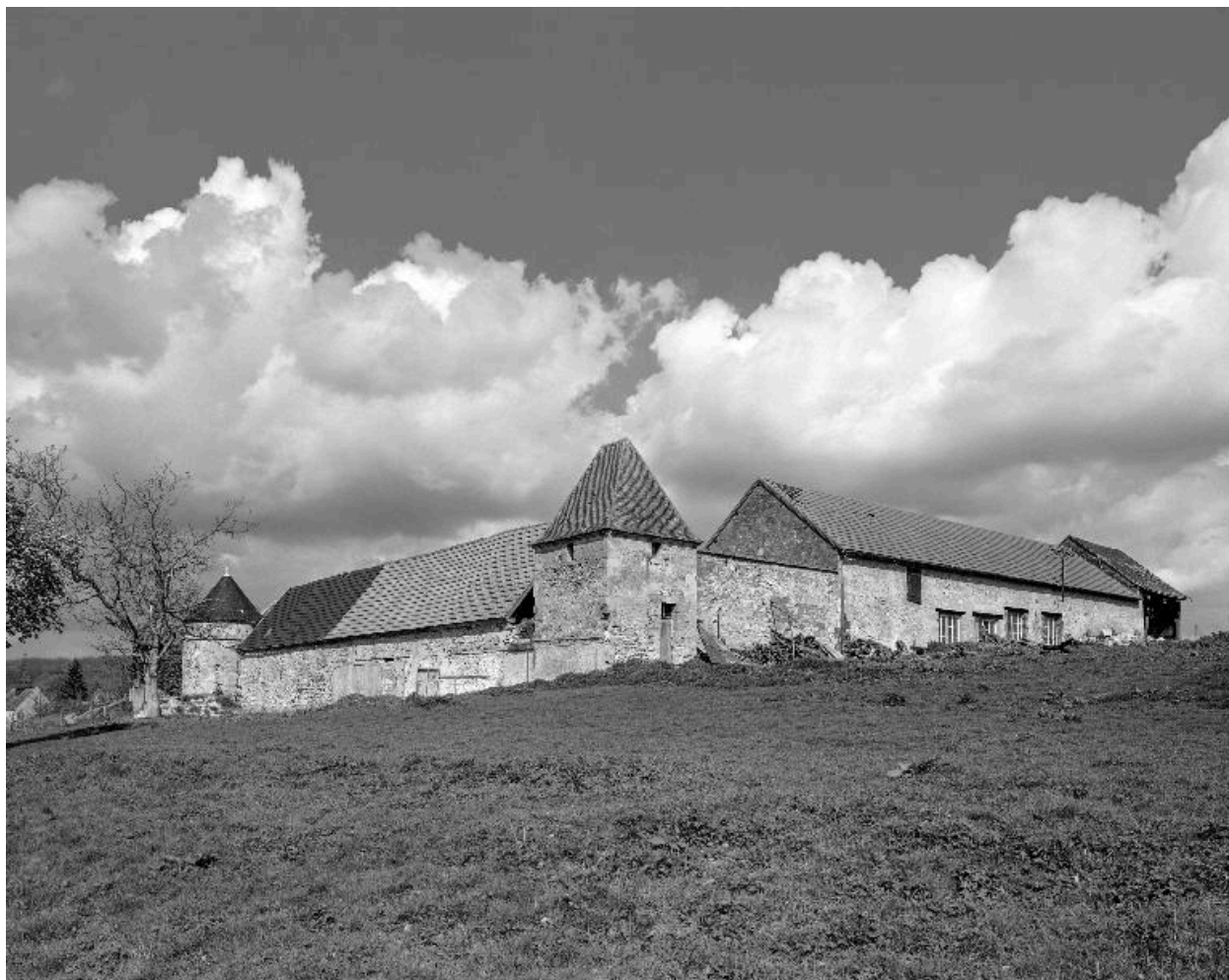
Vue de l'élévation externe des bâtiments sud-ouest et sud-est, depuis le sud.
