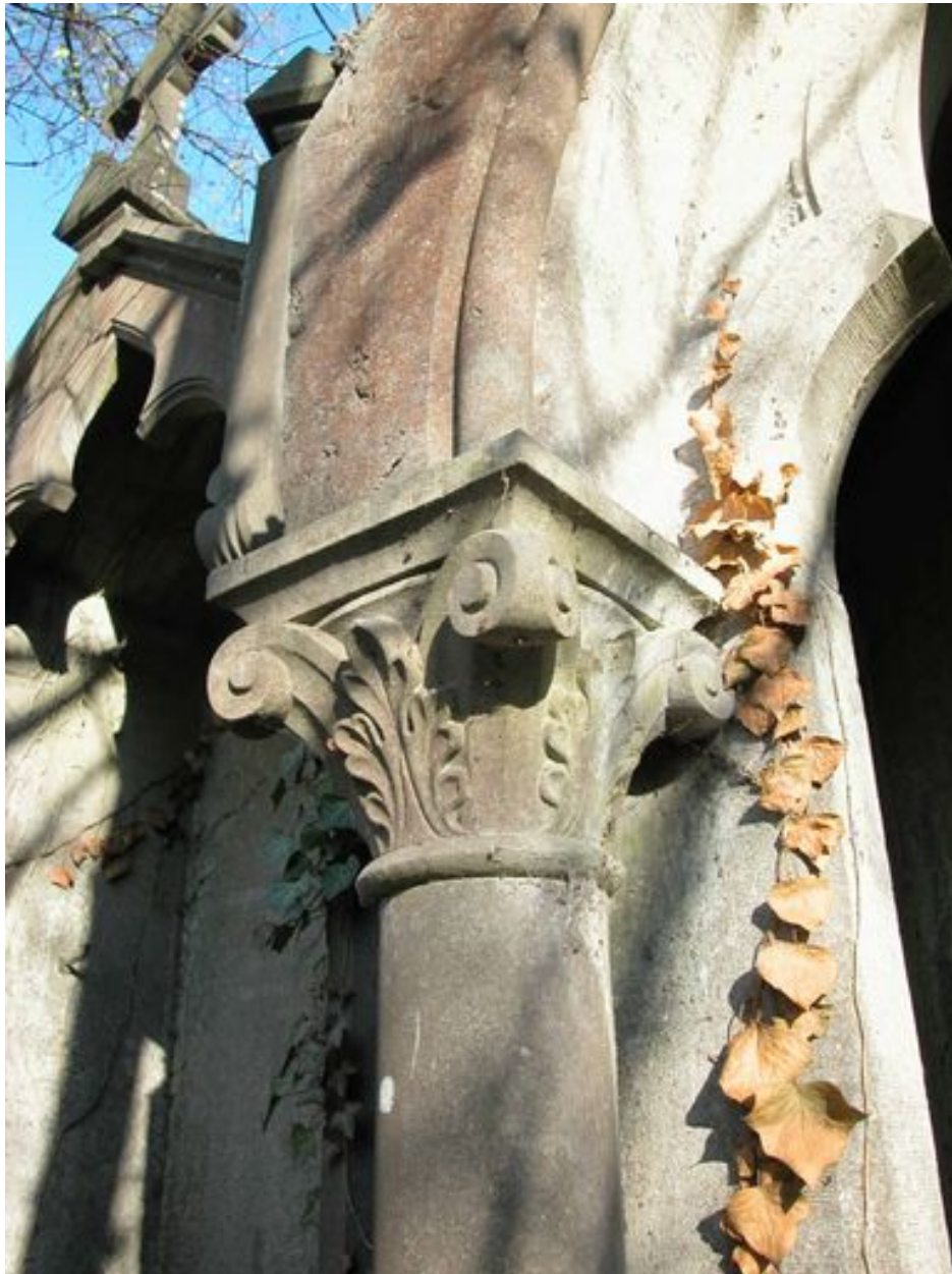
Détail d'une colonne.
