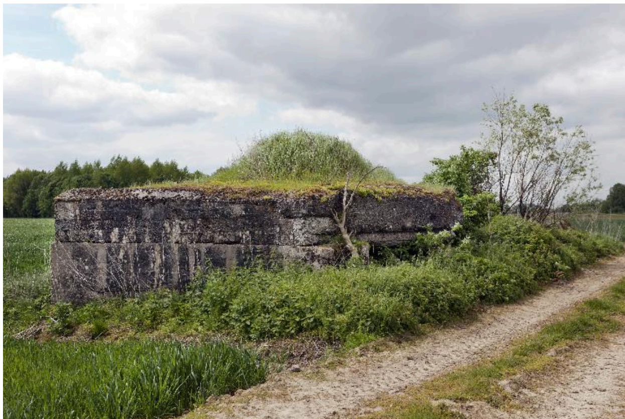
Vue latérale, vers sud-ouest
