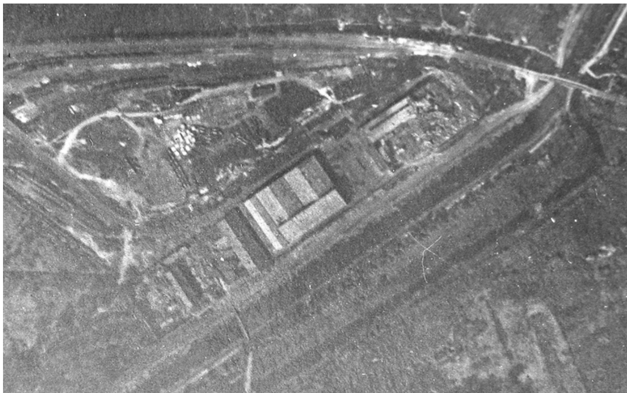
Vue aérienne du site en juin 1918 (AD Aisne).
