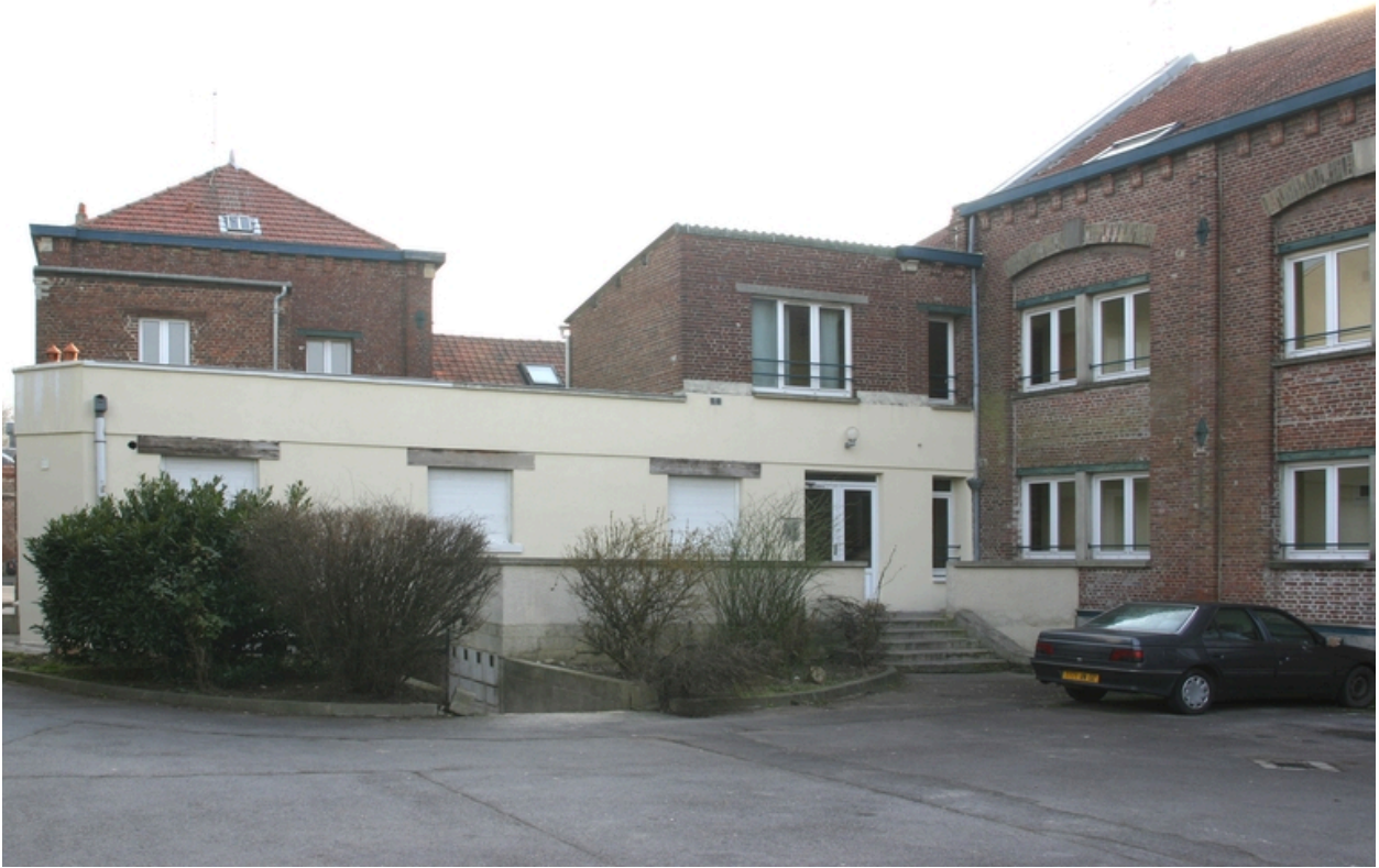
Façades postérieures des anciens bureaux, magasins et bobinage.
