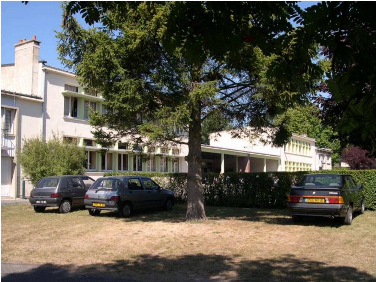
Classes et logements, à l'ouest de l'avenue.
