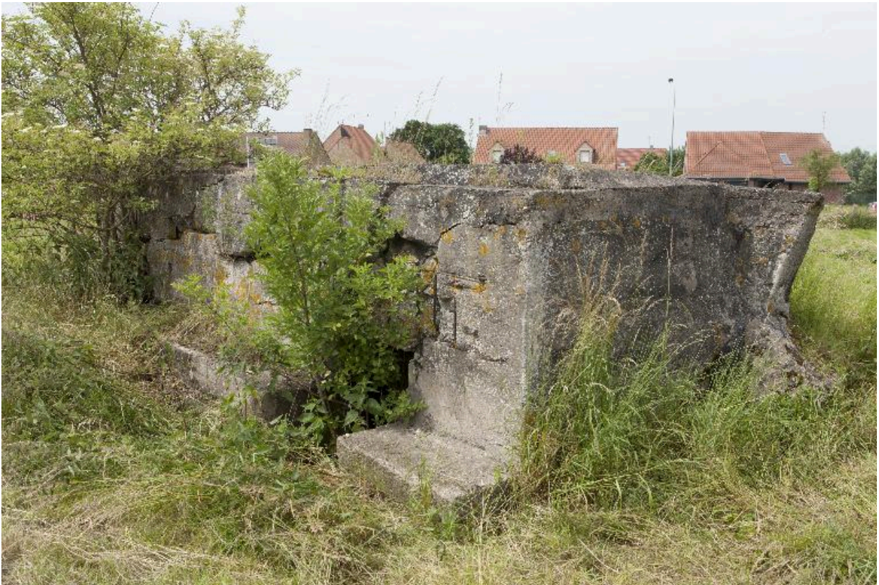
Casemate b. Banquette de tir, vers sud-ouest
