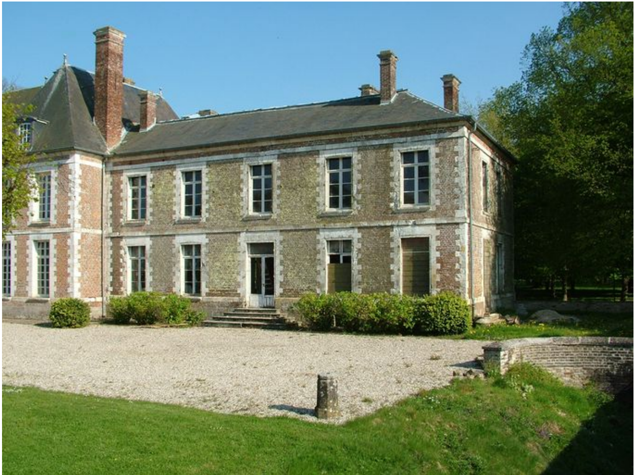
Corps de logis moderne, vue sur cour.
