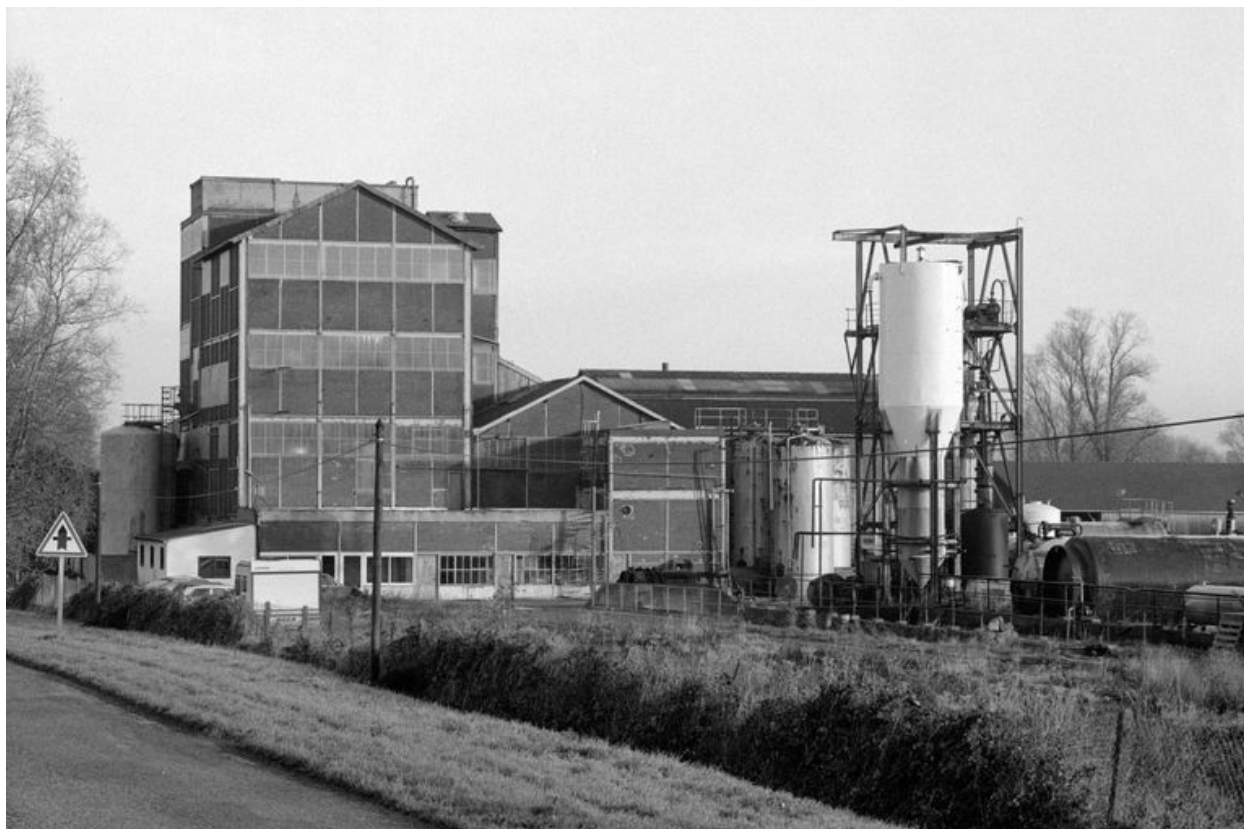
Vue d'ensemble, flanc sud.
