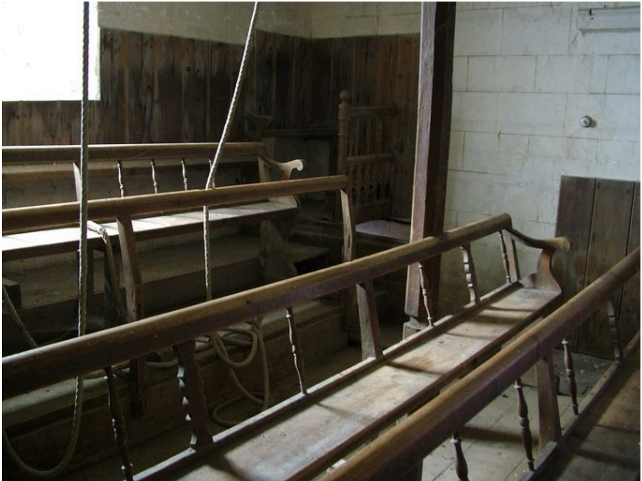
Vue générale des bancs de fidèles occupant la tribune.
