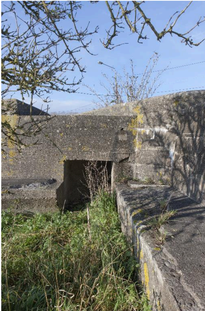
Accès pare-souffle à l'entrée ouest
