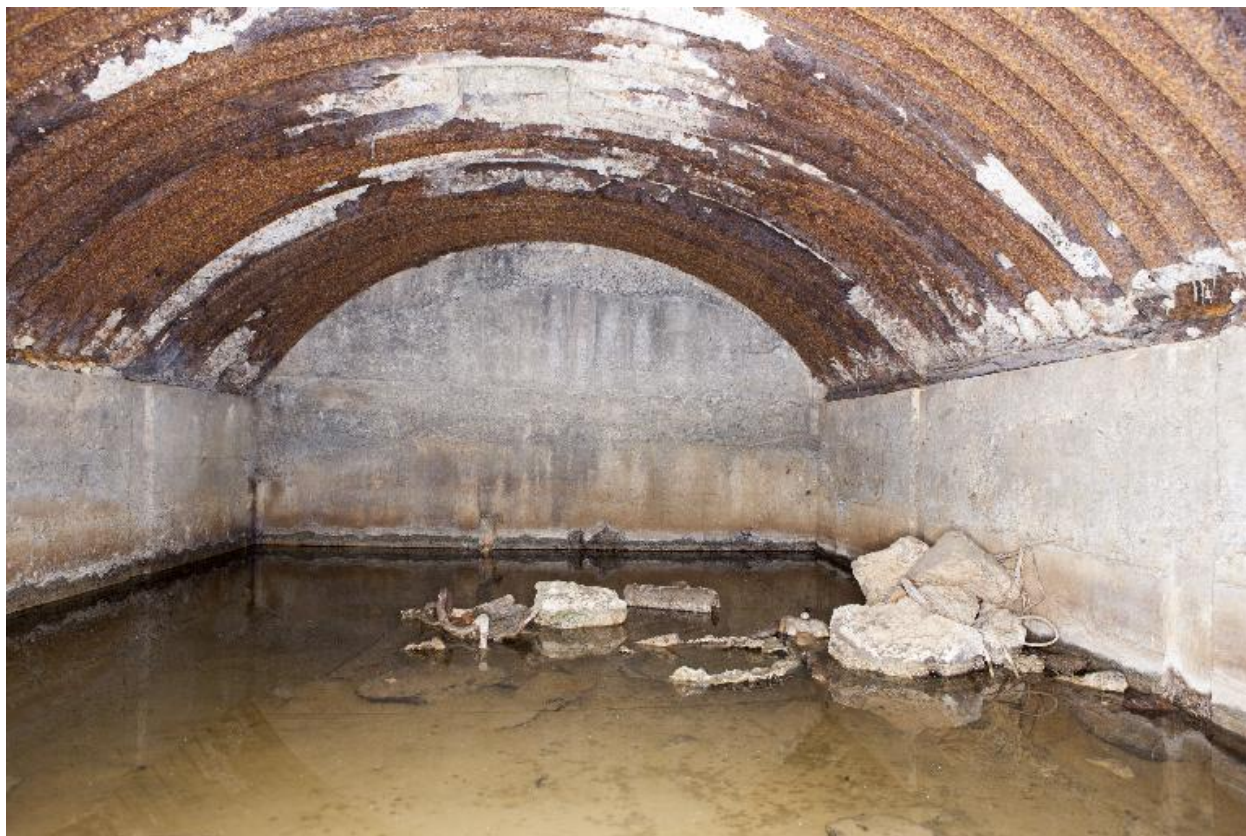
Vue intérieure vers le nord-ouest
