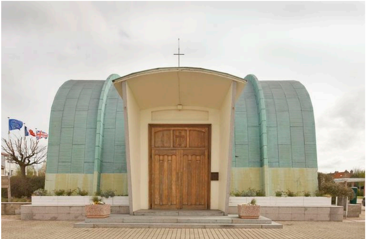
Vue de la façade.
