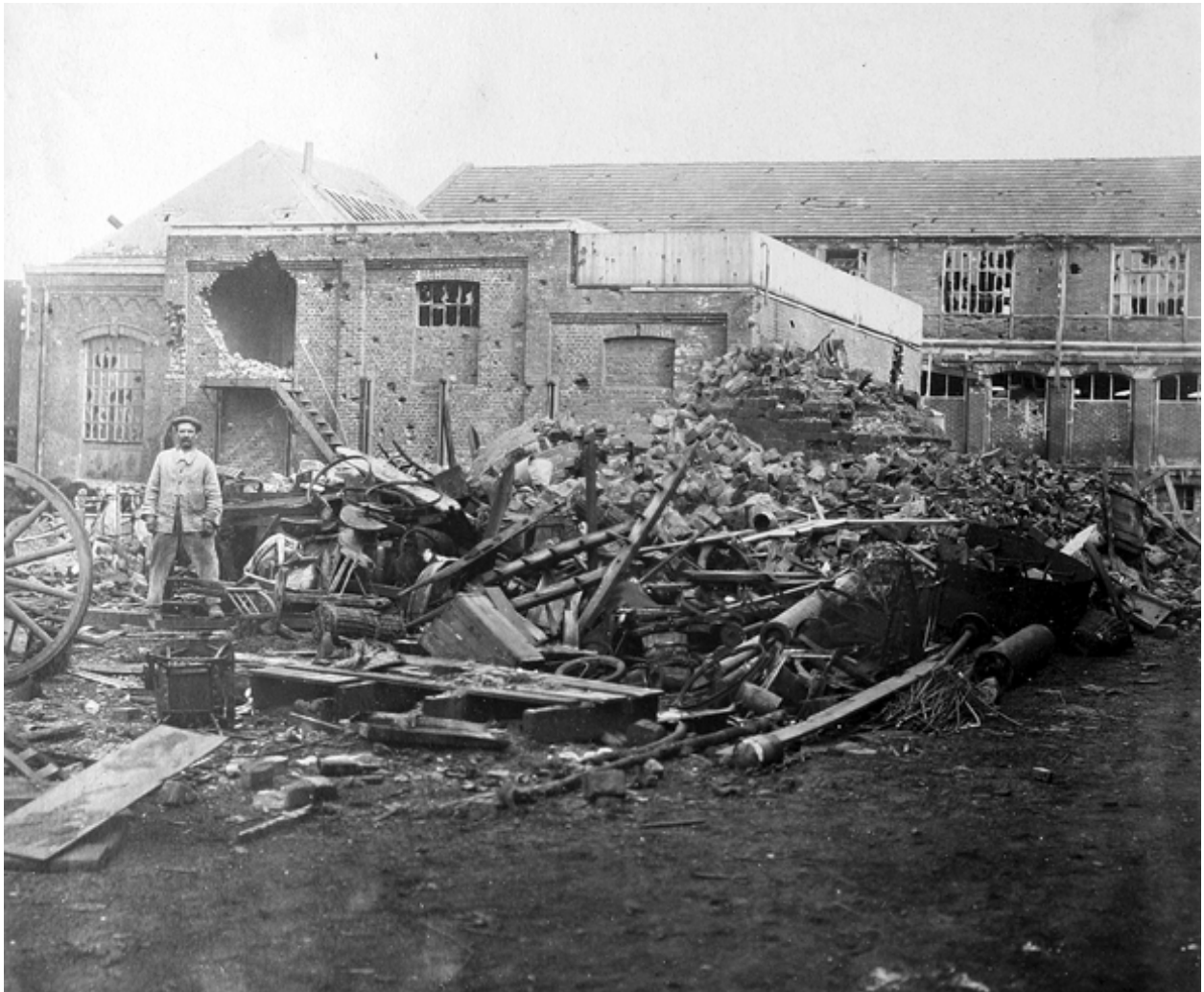
Salle des machines en ruine au premier plan, et façade ouest de l'atelier d'apprêt et bordage, par Brassart-Mariage, mai 1919 (AD Aisne).
