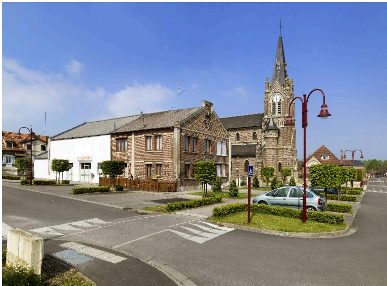
L'ancienne salle des fêtes de l'entreprise et l'église paroissiale.
